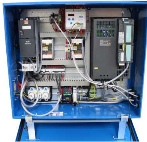
ABUS elektro 3 med frekvensomformer ABULiner for kjøring og/eller løfting
