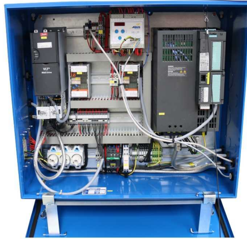
ABUS elsystem 3 med frekvensomretter ABULiner krankørsel/løbekatkørsel
