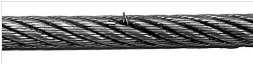
Kabelbrudd med utstikkende tråd.
