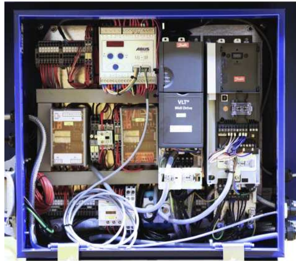
Sistema elettrico 3 ABUS con convertitore di frequenza ABULiner Traslazione e/o Sollevamento
