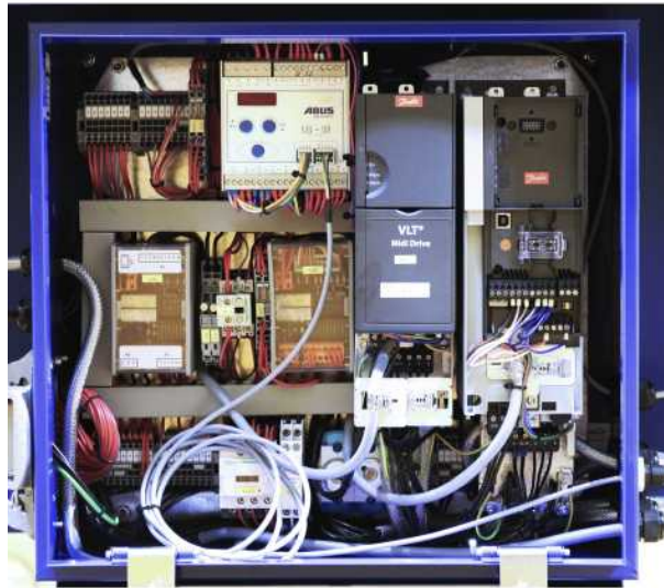
Ajoliikkeisiin ja nostoon tarkoitettu ABULiner-taajuusmuuttajalla varustettu ABUS-sähköjärjestelmä 3
