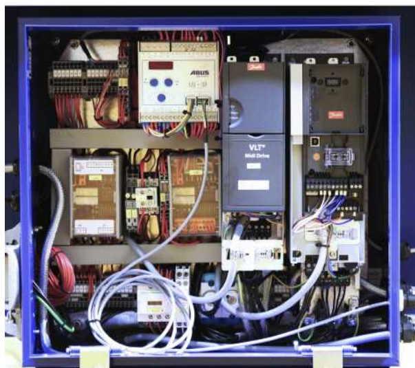
ABUS elsystem 3 med frekvensomretter ABULiner krankørsel/løbekatkørsel
