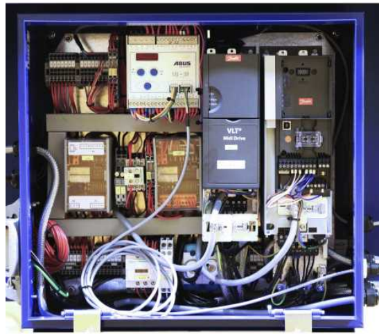
ABUS Elektrics 3 z przetwornicą częstotliwości ABULiner jazdy i/lub podnoszenia
