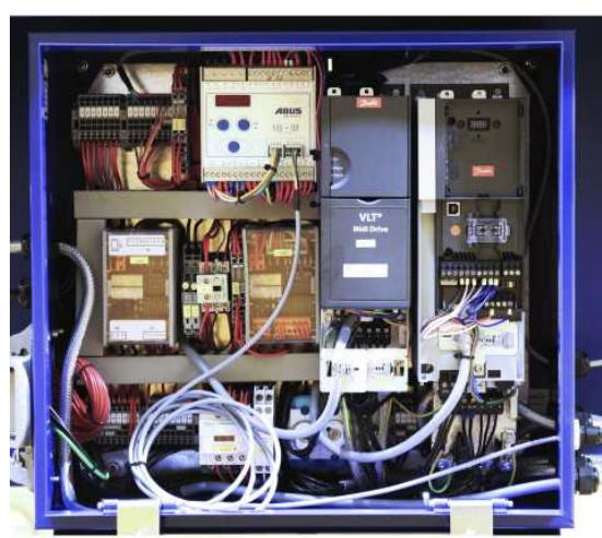
Ηλεκτρικό σύστημα ABUS 3 με σύστημα ελέγχου με ρελέ Ηλεκτρικό σύστημα ABUS 3 με μετατροπέα συχνότητας ABULiner Οδήγηση ή και Ανύψωση
