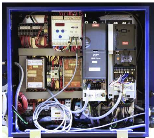
ABUS elektrický systém 3 s frekvenčním měničem ABULiner pro jízdu a/nebo zvedání
