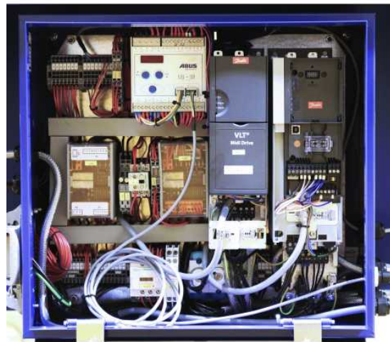
ABUS elsystem 3 med frekvensomretter ABULiner krankørsel/løbekatkørsel
