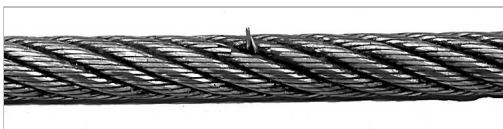
Kabelbrudd med utstikkende tråd.
