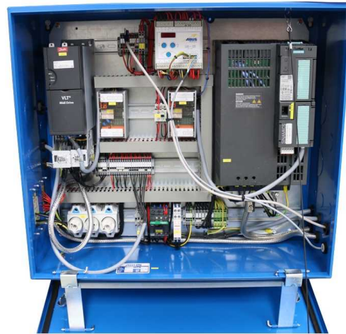
ABUS elsystem 3 med frekvensomretter ABULiner krankørsel/løbekatkørsel
